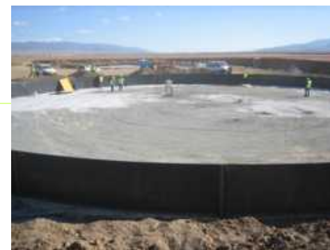
Budowa zbiornika roztworu soli
